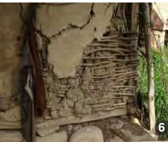
Detaliu de parament al unei case din lemn: tencuială din lut cu armătură din nuiele.
