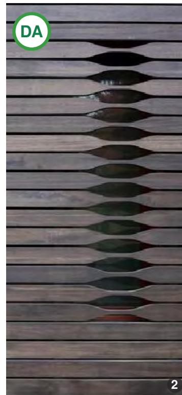
**AŞA DA:** Crearea unei zone prin care pătrunde lumina poate fi realizată prin traforarea discretă a elementului de închidere.
