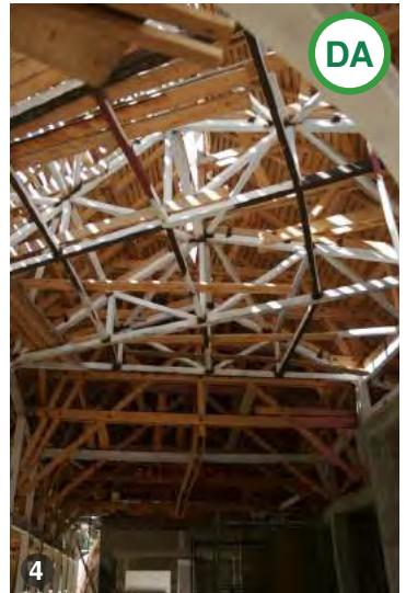
**AŞA DA:** Pentru construcții cu deschideri mari se pot folosi sisteme combinate de metal cu lemn.
