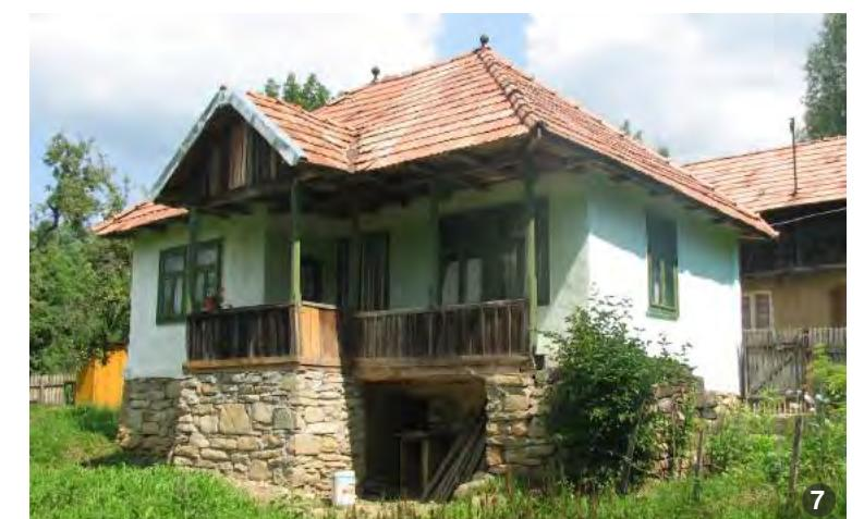
Casă cu pereți din lemn cu umplutură din pământ, așezată pe un beci construit din bolovani.
