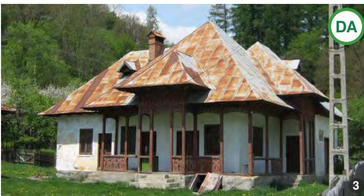
**AŞA DA:** Utilizarea unui acoperiș cu patru ape ce acoperă o clădire de formă dreptunghiulară, cu decroșuri care se citesc mai mult în planul acoperișului, dinamizează cu rafinament compoziția volumetrică.
