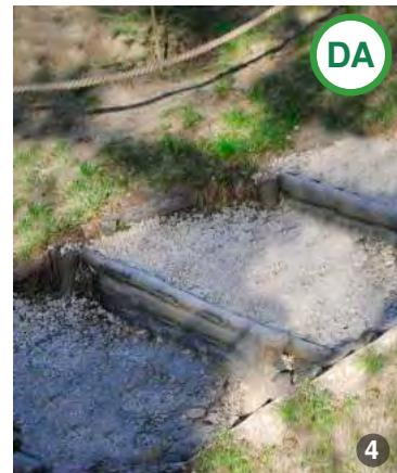
**AŞA DA:** Scări exterioare cu trepte din piatră și contratrepte din lemn rotund despăcat care se pretează pentru amenajări exterioare.
